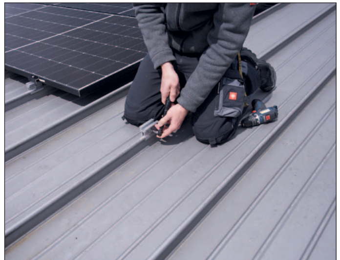
▲ Die Kombination zweier bauaufsichtlich zugelassener Montagesysteme erlaubt eine einfache und sichere Verlegung von PV-Modulen
