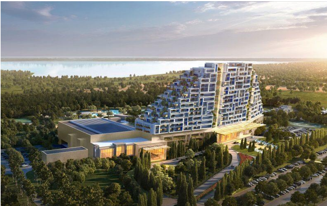
Ansicht des Gebäudekomplexes von hinten. Das geplante Kalzip-Dach erkennt man gut auf der linken Seite
