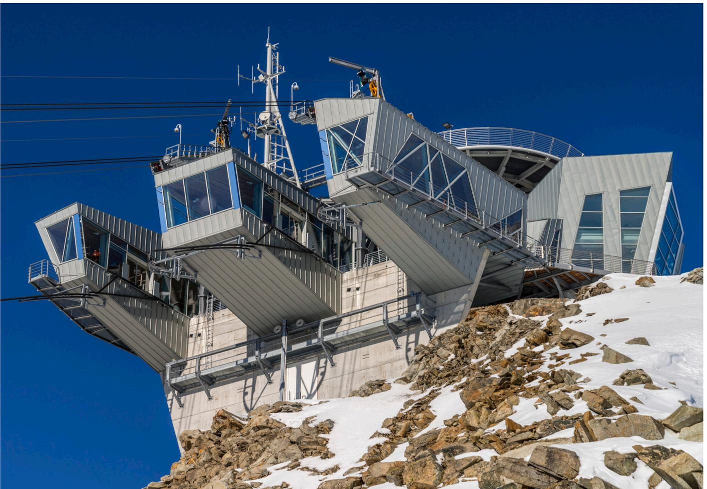
falz-Deckung. Auf die tragende Stahlkonstruktion wurden Stahlpfetten montiert. Darauf befestigten die Handwerker eine Holzbretterlage auf die wiederum eine 1,2 mm starke Kalzip Dampfsperre geklebt wurde. Den Dachabschluss bilden 0,7 mm dicke FalZinc® Aluminiumscharen.
