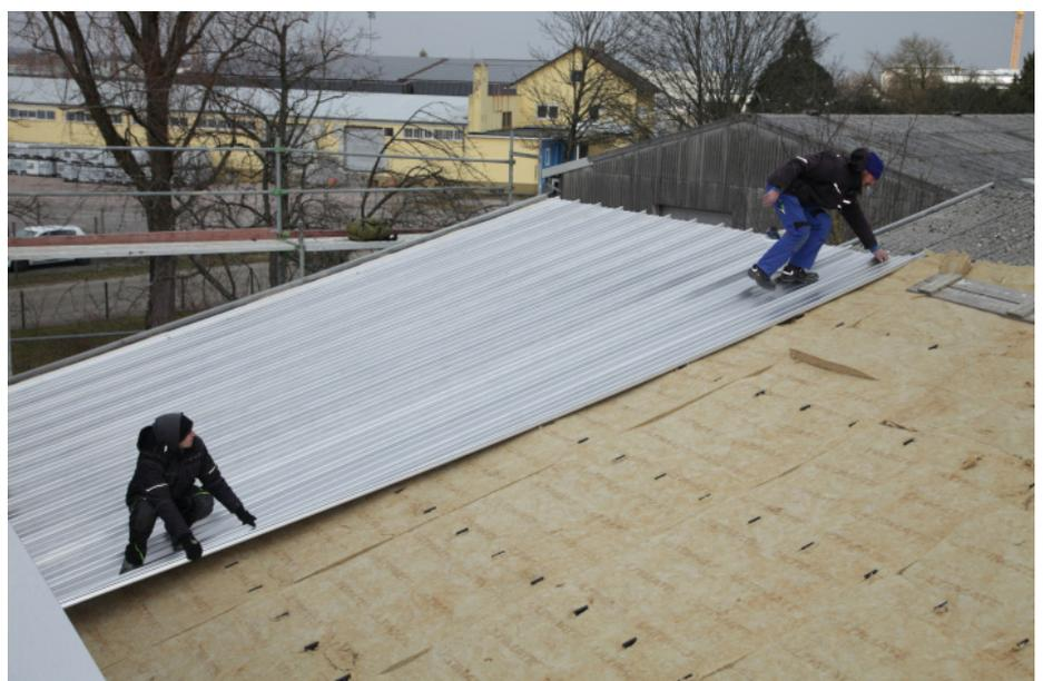
Der Bauherr, die Chrom Schmitt GmbH + Co. KG suchte nach einer dauerhaften Lösung, die sich trotz zusätzlicher Wärmedämmung auf das vorhandene Tragwerk montieren ließ und dabei auch die Anforderungen an den konstruktiven Brandschutz erfüllte. Alle Anforderungen ließen sich mit den Kalzip Profiltafeln aus Aluminium erfüllen.
