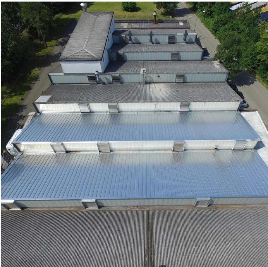
Dank der gewählten Dachmaterialien und des Bauablaufs konnte die Produktion des Bauherrn während der Sanierung uneingeschränkt weiterlaufen. Auf die neue langlebige und trotzdem wartungsarme Dachdeckung soll später eine PV-Anlage montiert werden. Sie lässt sich dann durchdringungsfrei mit bauaufsichtlich zugelassenen Bördelklemmen auf die Rundfalze befestigen, was ein weiteres Vorteil des innovativen Sanierungskonzepts von Kalzip darstellt.
