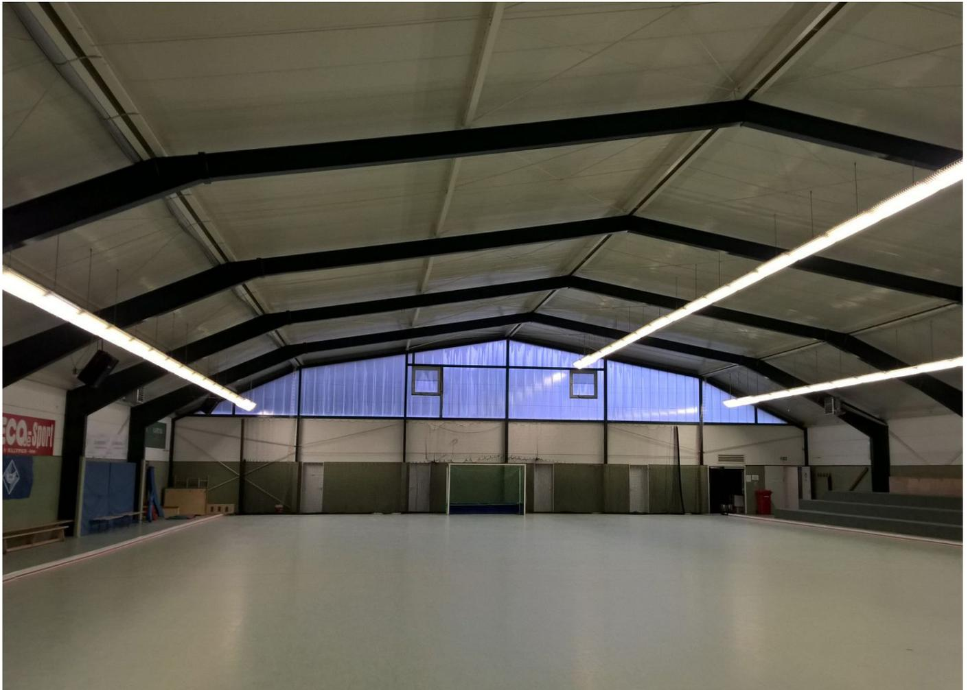
Viele Dächer älterer Sporthallen sind heute sanierungsbedürftig und entsprechen nicht mehr den aktuellen Anforderungen der EnEV. Eine Sanierungslösung mit Kalzip Profiltafeln aus Aluminium erlauben oftmals die Ausnutzung vorhandener statischer Reserven der bestehenden Dachkonstruktion bei gleichzeitigem Verbleib der bestehenden Dachdeckung. Dies spart nicht nur Entsorgungskosten, auch die Sanierung kann meist
