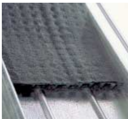
Le support de drainage Kalzip® est fourni en rouleaux. Il est installé dans les plages des bacs Kalzip®.
