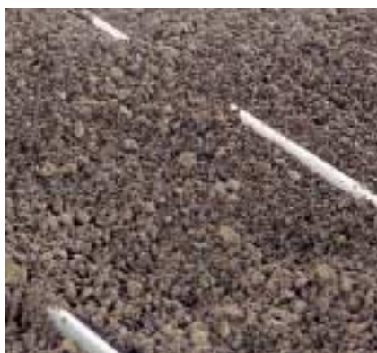
La sous-couche végétale a une épaisseur d'environ 7 cm. La mise en place sur des toitures difficiles d'accès peut se faire par projection.
