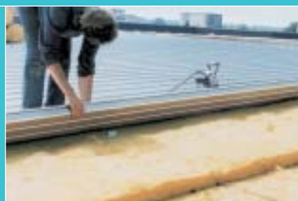
*Toiture chaude Kalzip® AF avec isolation dans l'assemblage de lattes
