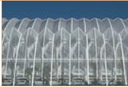
links und rechts: Kalzip® Stehfalzprofile krönen Calatravas „Museo de las Ciencias“ unten: Konstruktion des bogenförmigen Satteldaches
