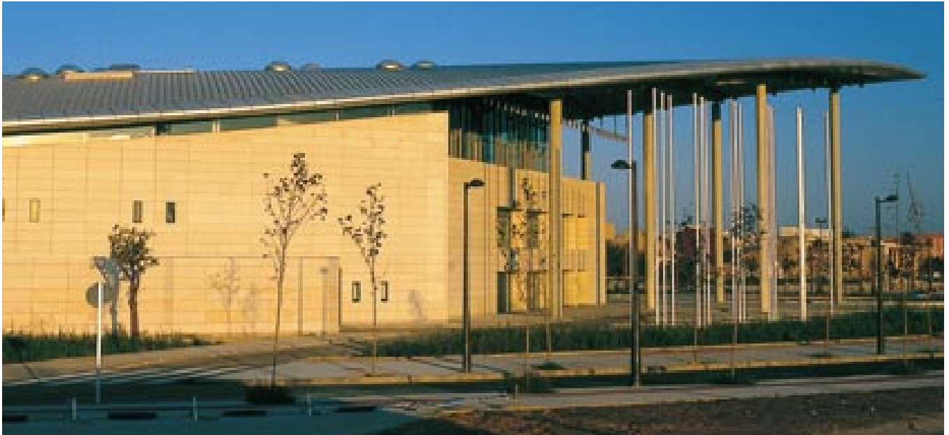
Auf der Südseite kragt das Dach weit über und signalisiert zusätzliche Bedeutung: geschützte Vorfahrt und Schattenspender vor dem Eingangsbereich.
