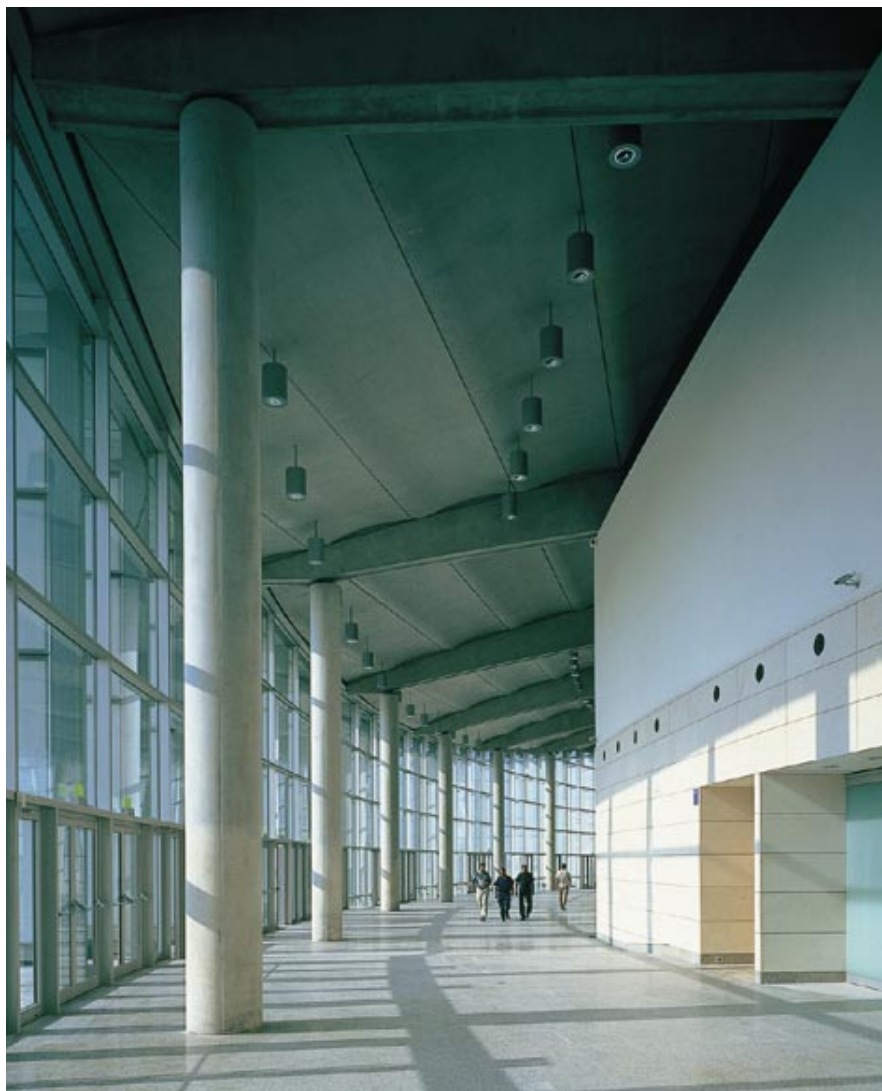
Die hohe Transparenz ermöglicht die Tageslichtspiele in der großen Halle auf der Ostseite.
