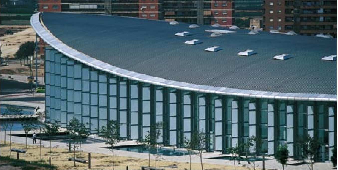
Für den Einbau von Lichtkuppeln oder RWA-Anlagen werden speziell angepasste Aufsatzkränze angefertigt.
