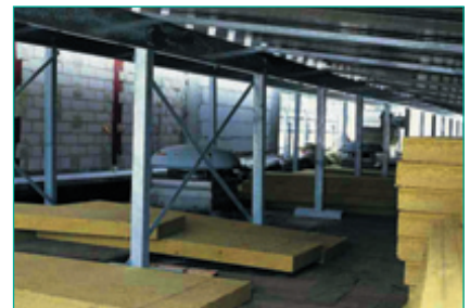
Aufbringen der zusätzlichen Wärmedämmung
