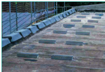
Montage der Verankerungswannen
