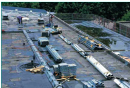
Lieferung der Stahl-Leichtkonstruktion
