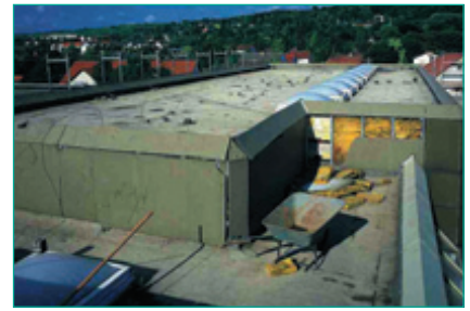
Ggf. Entfernen der Kiesschüttung
