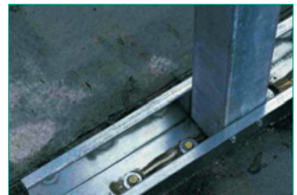
Montage der Stützen
