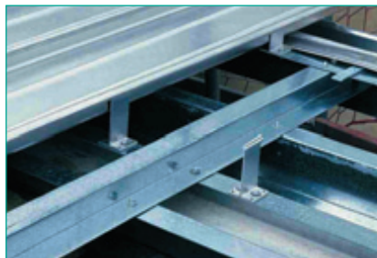
Montage der Kalzip® Profiltafeln
